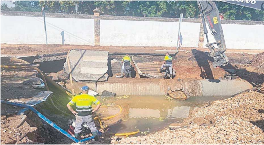
Los operarios de Agua del Huesna estuvieron trabajando durante todo el día para reparar la tubería y restablecer el suministro.
